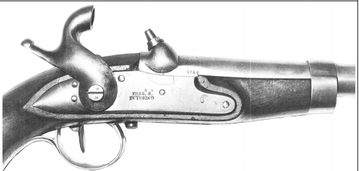
Particolare della pistola. Si notano la rappezzatura alla cartella dell'acciarino e il tipico portaluminello delle armi ridotte.
